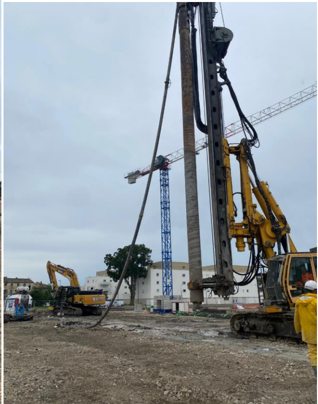
Réalisation d'un pieux
