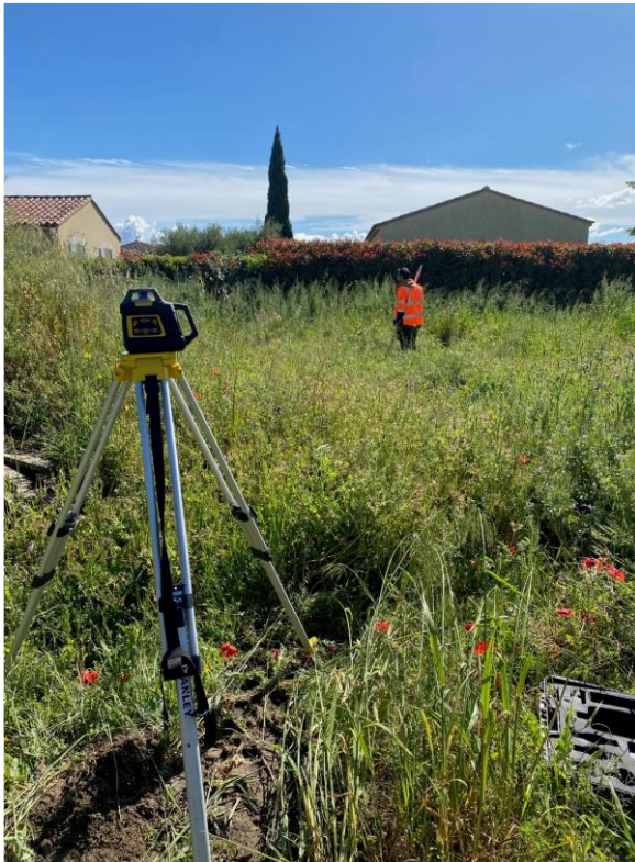
Niveau de chantier avec laser
