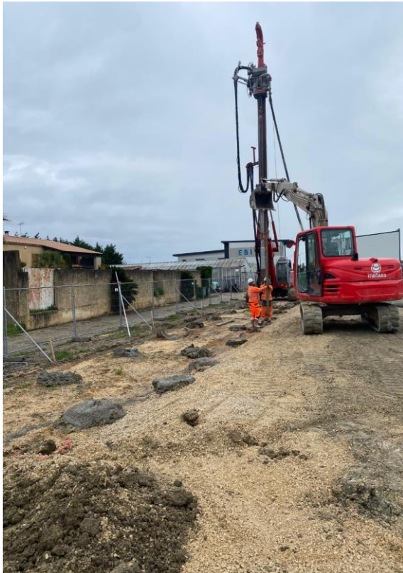
Réalisation des inclusions
