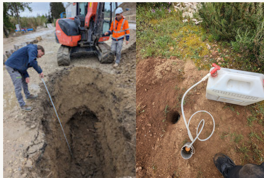
PHOTOS DES SONDAGES ET ESSAIS D'INFILTRATION EN ANC
