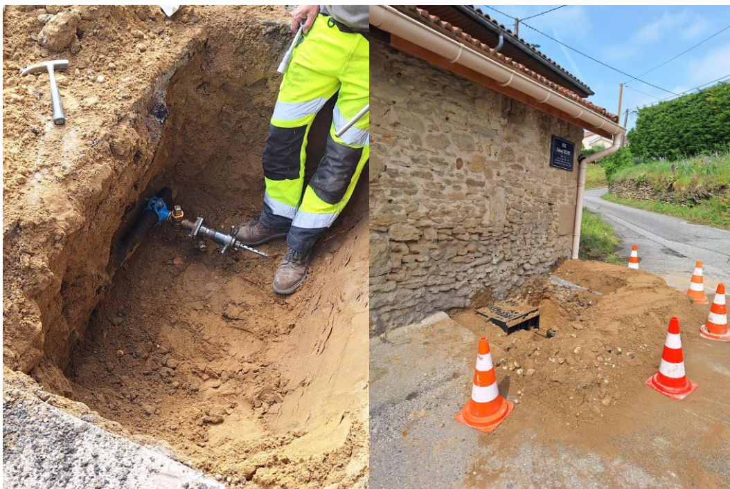
Pose d'un compteur abonné
