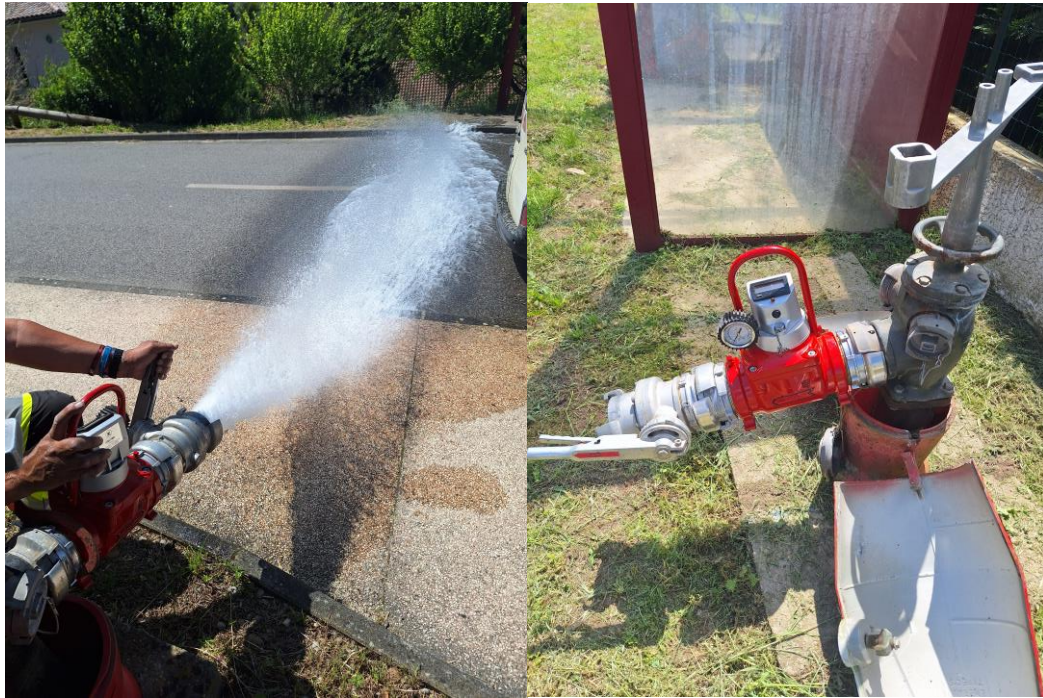
Test de vérification des pressions des bornes d'incendie
