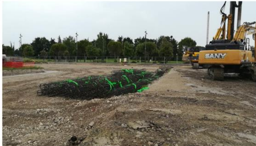
Armatures des pieux secondaires en attente
