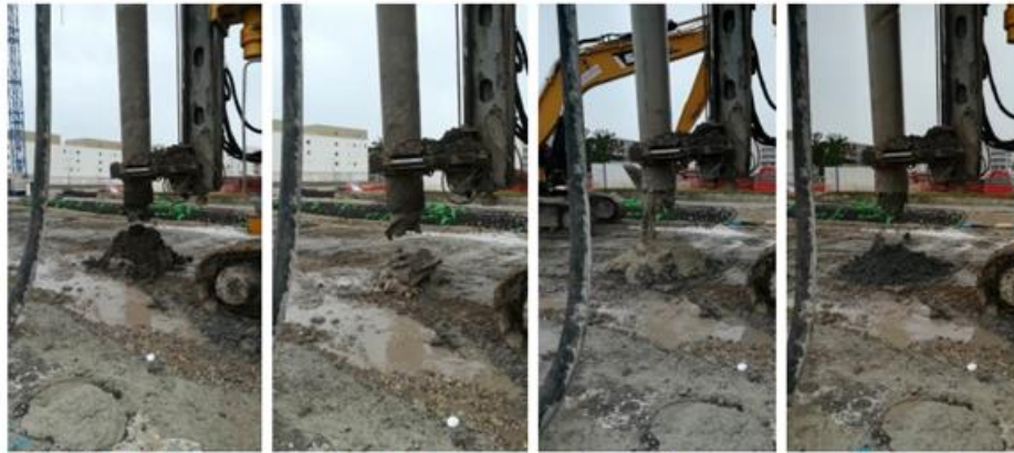
Remblais de surface Limons mous Graves sableuses Marnes grises Cuttings extraits du tubage lors du forage du pieu n°171 - de haut (à gauche) en bas (à droite)
