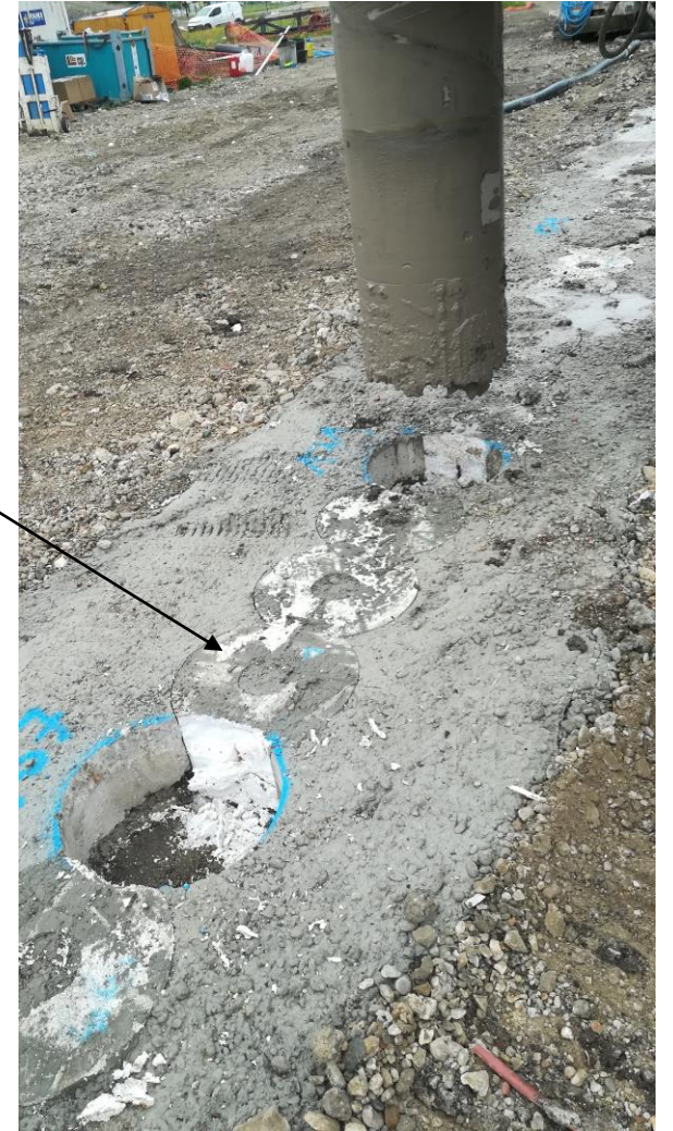
Réalisation d'un pieu
