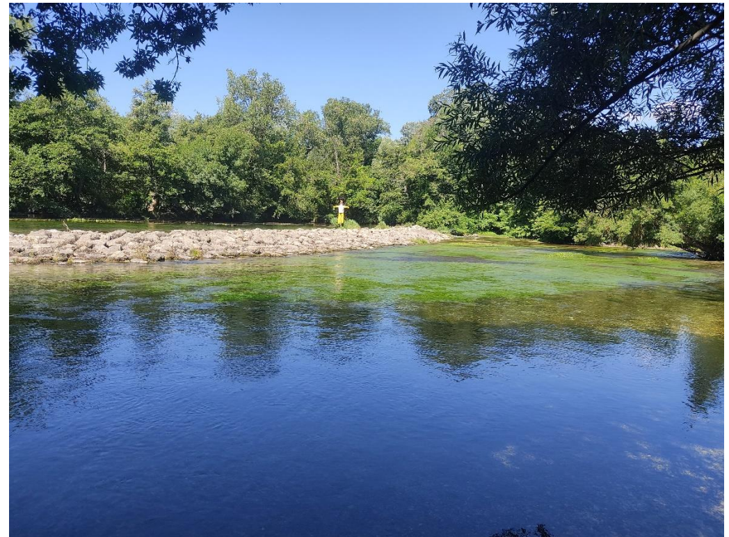
Photographie du seuil de Fontanelle
